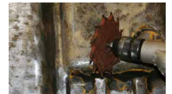
Entfernen von Unterbodenschutz
