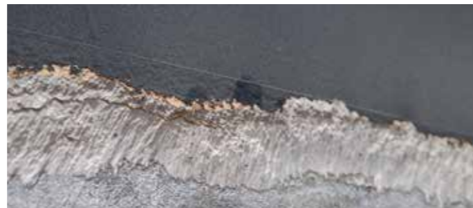
Entfernen von Grundiermasse
