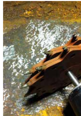
Entfernen von Rost
