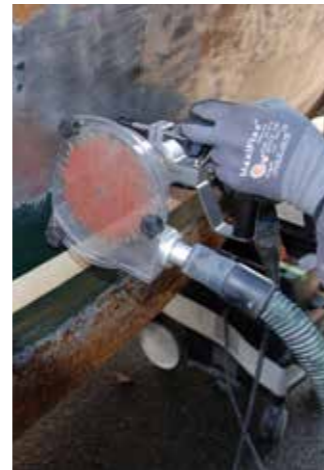
Entfernen von Farbe mit Absaugstaubschutz und Abstandhalter
