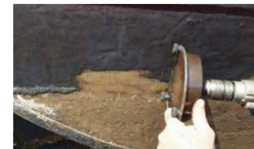
Entfernen von Rost
